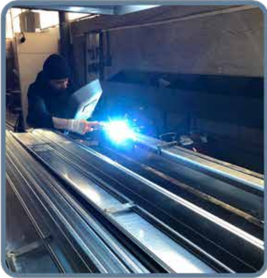
Çelik takviye işlemi(Güçlendirme)
