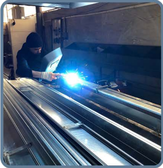
Çelik takviye işlemi(Güçlendirme)
