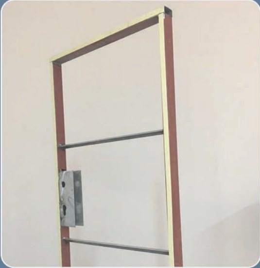
İç Kapı kanat iskelet görünümü
